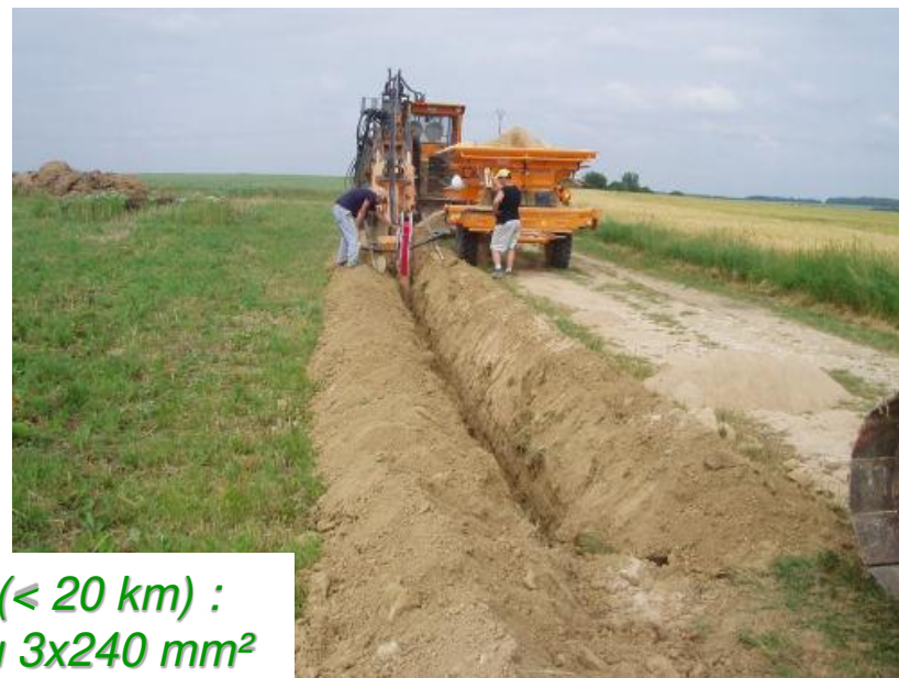
Enfouissement câbles : 0,5 à 1 m de profondeur
