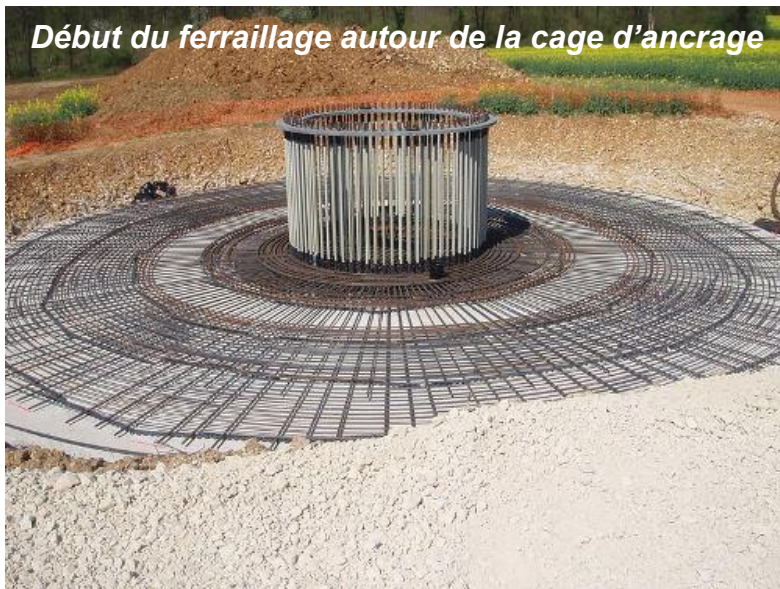
Cage d'ancrage servant de virole
