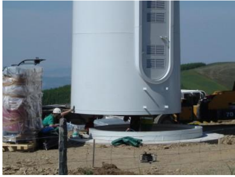
Assemblage des tronçons de mât
