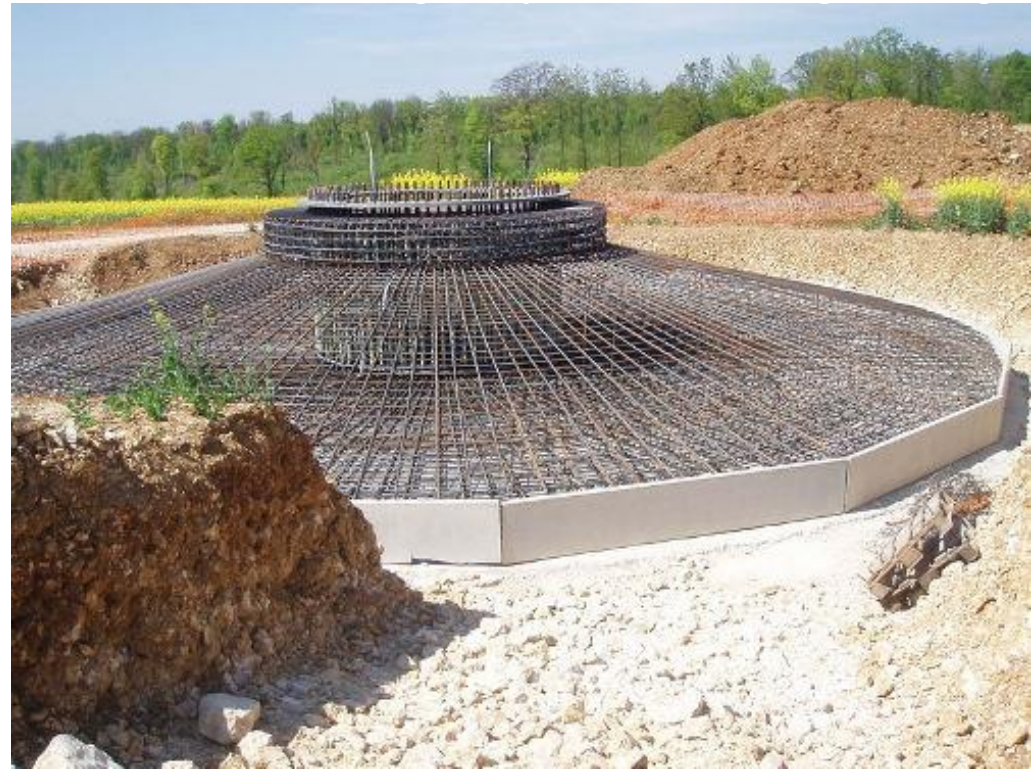
Cage d'ancrage servant de virole
