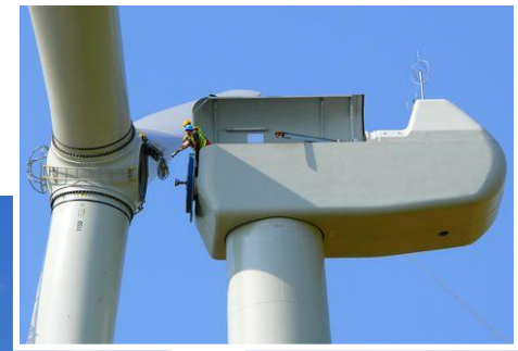
Assemblage du rotor
